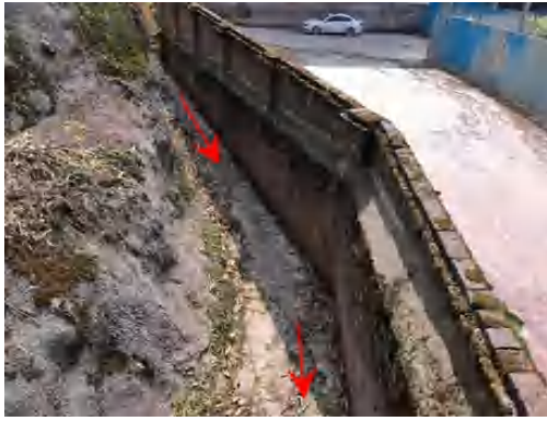
围墙外的雨水收集沟 1
