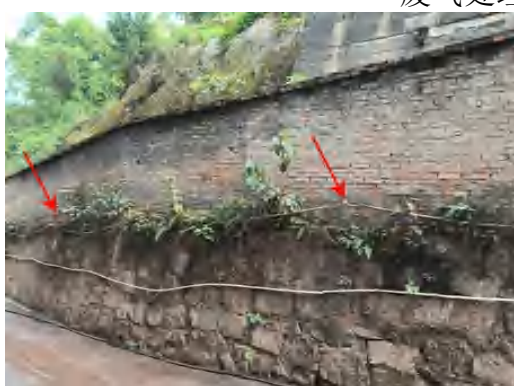
围墙上的防尘喷雾系统 1
