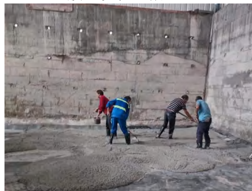
膜上浇筑混凝土 3
