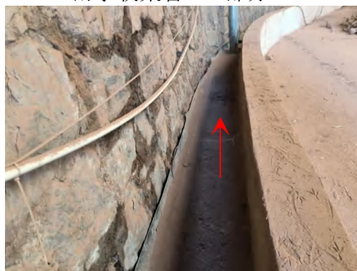
围墙内的雨水收集沟 1
