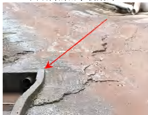
收集的雨水导流至围墙内的雨水收集沟
