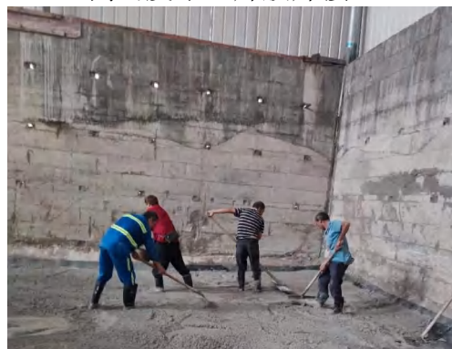
膜上浇筑混凝土 2
