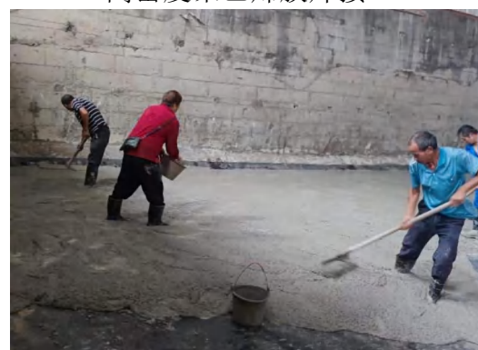
膜上浇筑混凝土 1
