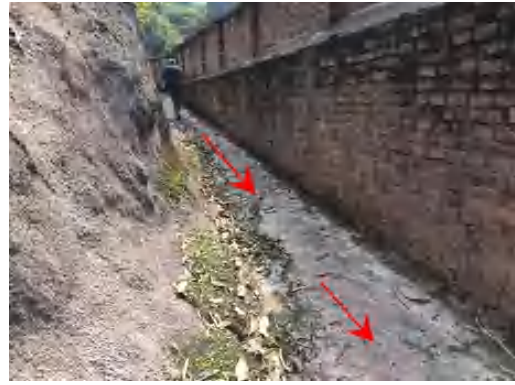
围墙外的雨水收集沟 2
