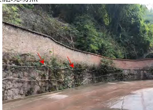
围墙上的防尘喷雾系统 2
